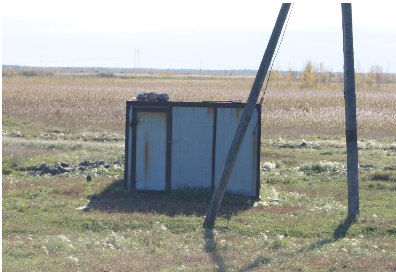
Рисунок 2.2 – Павильон скважины № ВА-46 системы централизованного водоснабжения д. Чаны-Сакан
